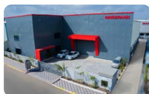
RINGSPANN Power Transmission India Pvt. Ltd., Indien
